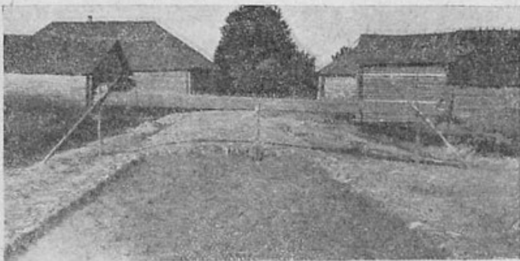
Устройство мостовой в деревне
